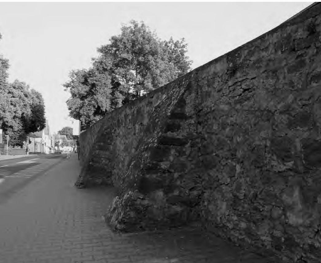
Die nordöstliche Mauer an der Hinserdorfstraße hat sich bis heute ihren wehrhaften Charakter bewahrt.
