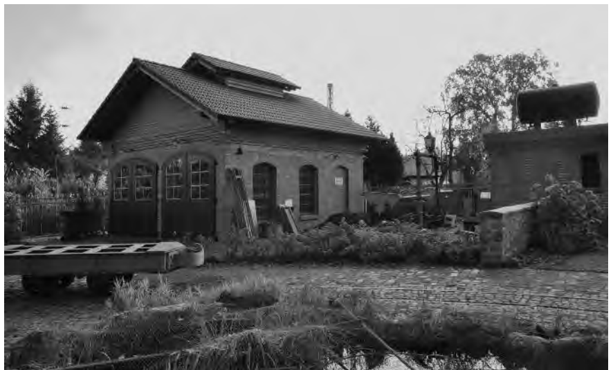
Das Foto zeigt das Bahnbetriebswerk der Schmalspurbahn bestehend aus Wasserturm, Wasserkran, Kohleberg und zweistöndigem Lokschuppen. Im Vordergrund ein Schwerlastbahnwaggon für 36 t Zuladung im Hintergrund zwei Kipploren.
