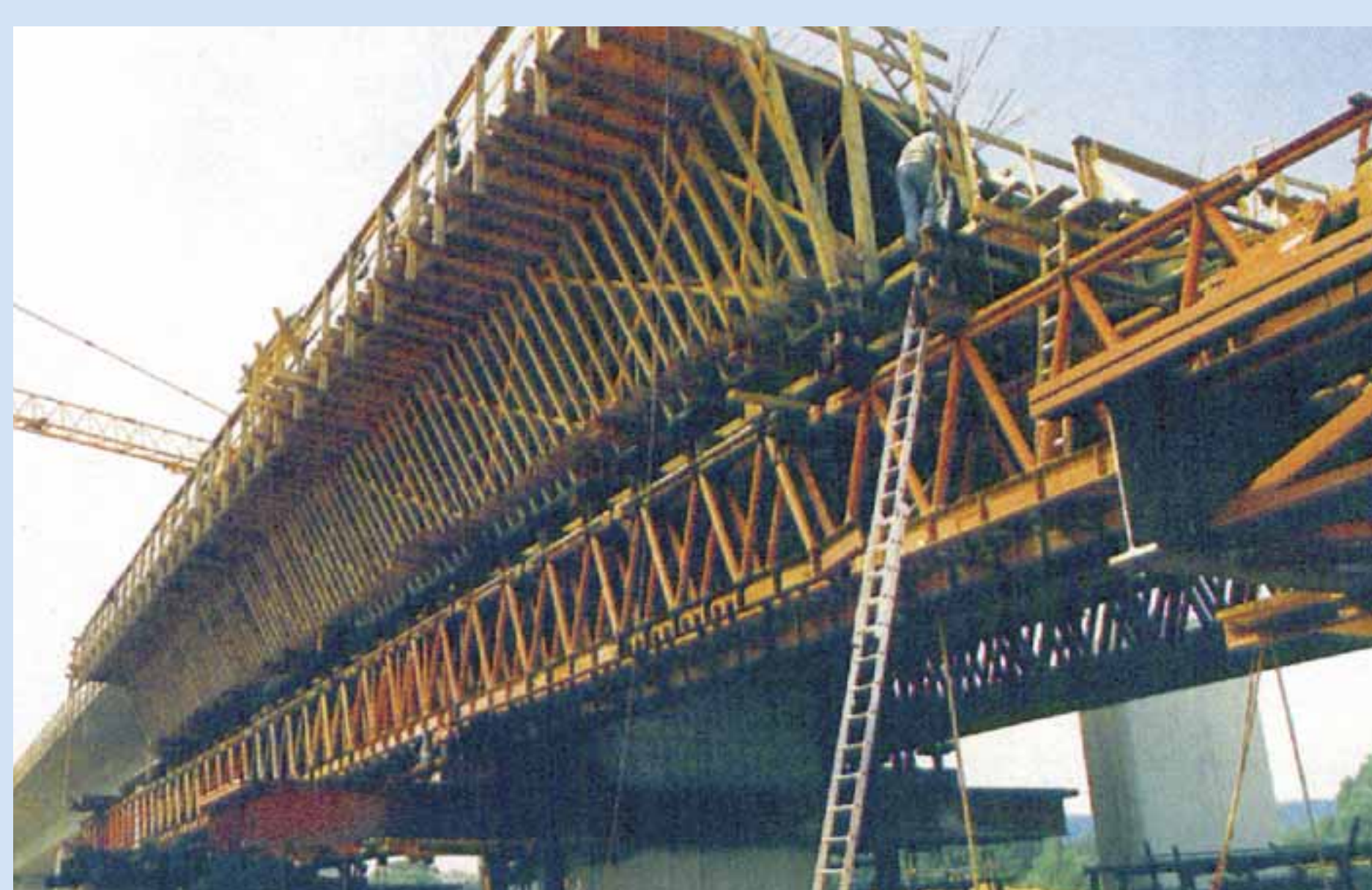
Bau der 985 Meter langen, vierspurigen Kinzigtalbrücke.
