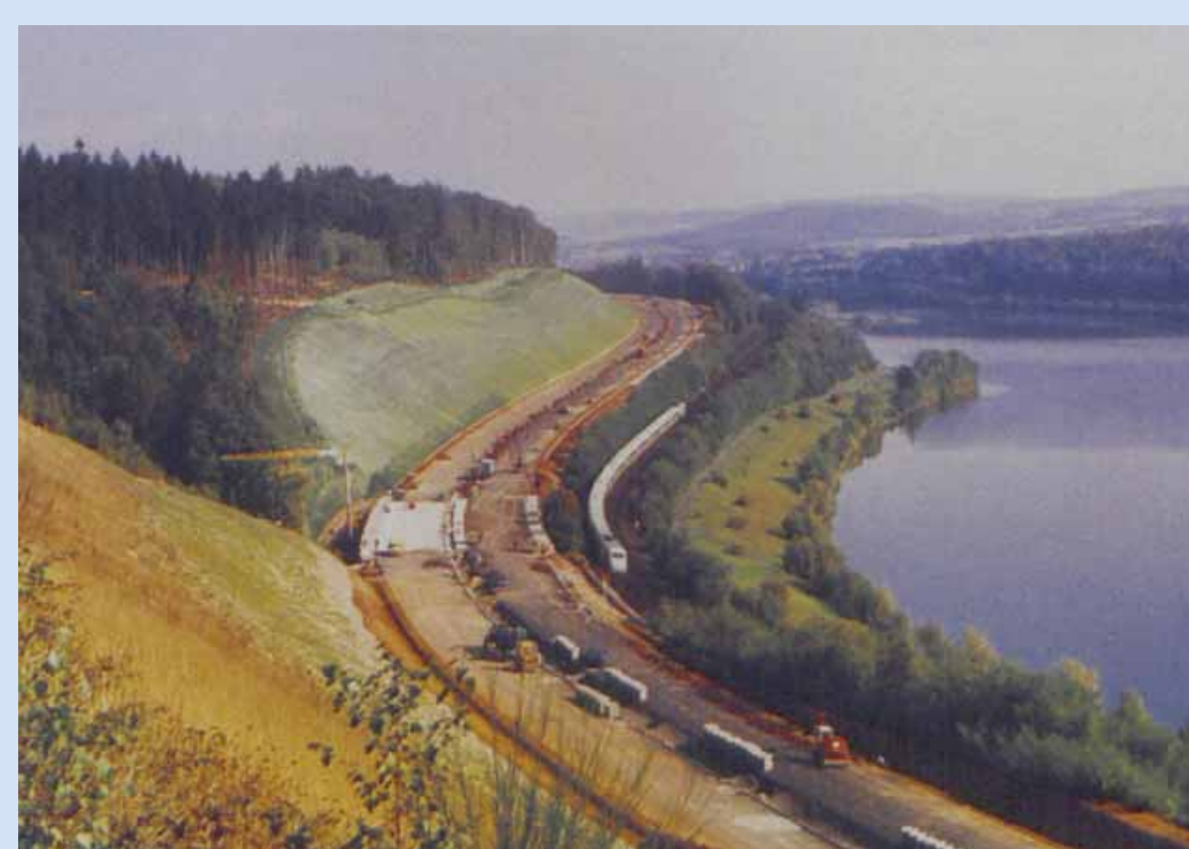
Der Autobahnabschnitt Ahl – Distelrasen im Bau: Zwischen Ahl und Steinau teilen sich Autobahn und Zugtrasse den Hang nördlich der Kinzigtalsperre.
