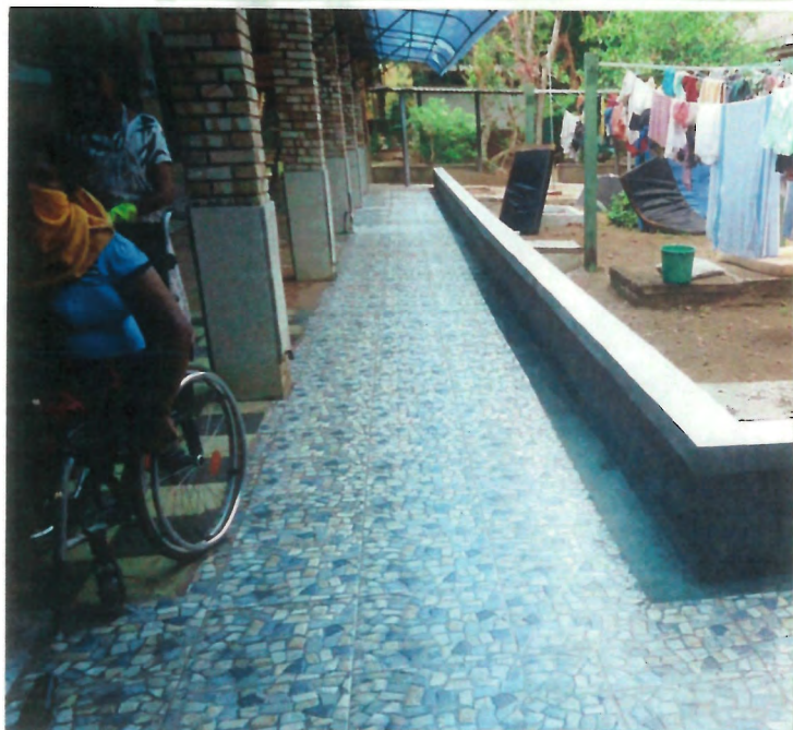
Neubau einer überdachten, rollstuhlgerechten Terrasse im Waisenhaus "MAMA und PAPA" für geistig und körperlich behinderte Kinder.
