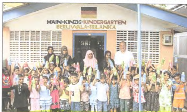
Der Main-Kinzig-Kindergarten war eines der ersten Projekte direkt nach dem Tsunami. Die Kontrolle des Zustandes und Instandhaltung der „alten“ Investitionen gehört immer zum Programm der Reisen von Karl Eyerkauf.
